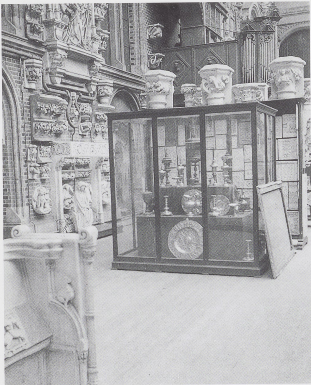
Afb. 2 Zuidwesthoek van de Gipsbinnenplaats met onder meer de vitrine met galvanoplastieken van de Poptaschat, circa 1905.
