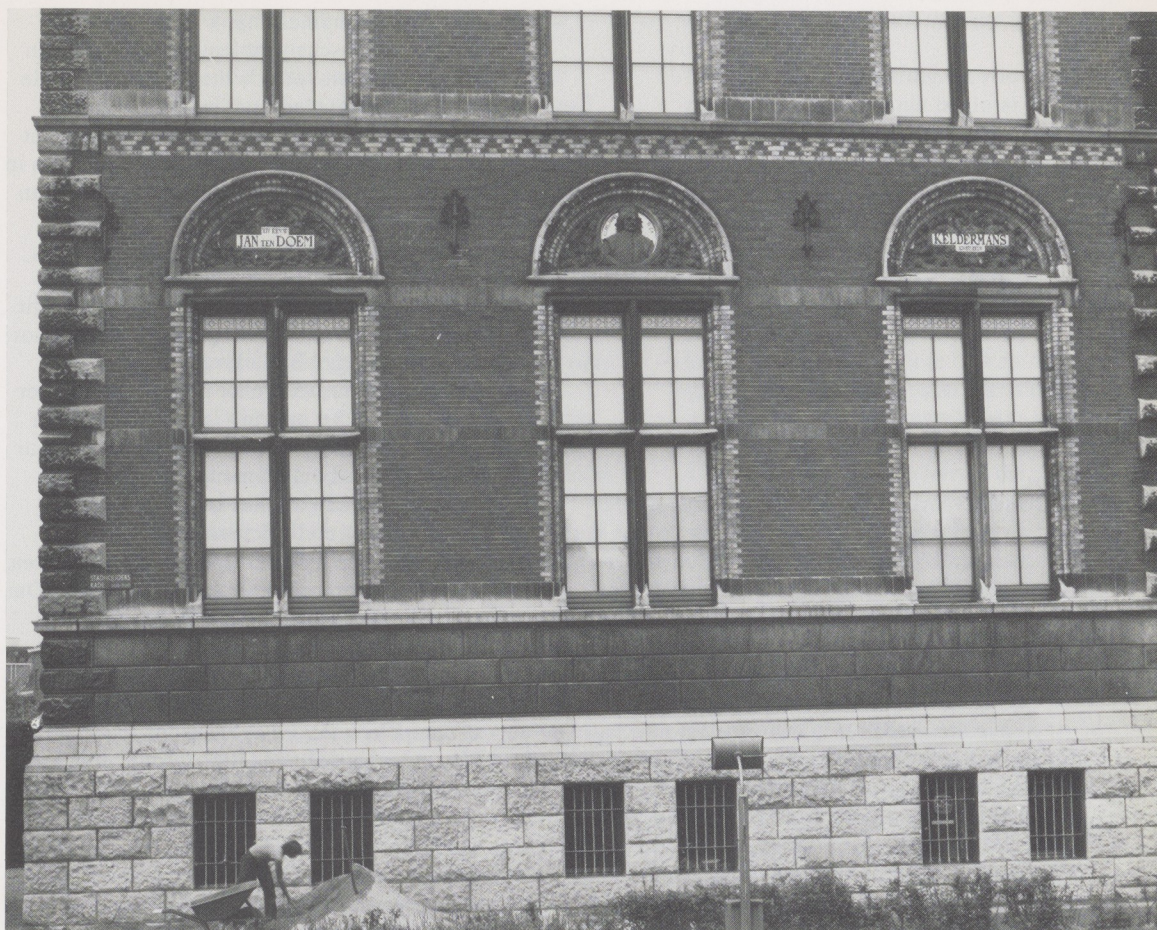
Afb. 11. De vensters aan de oostzijde van het Rijksmuseum met de karakteristieke roedenverdeling, die architect Quist wilde veranderen.
