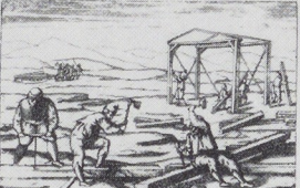
1597 - 25 september Het huis werd gebouwd van drijfhoet, volgens een ontwerp van de timmerman die op 23 september was overleden
