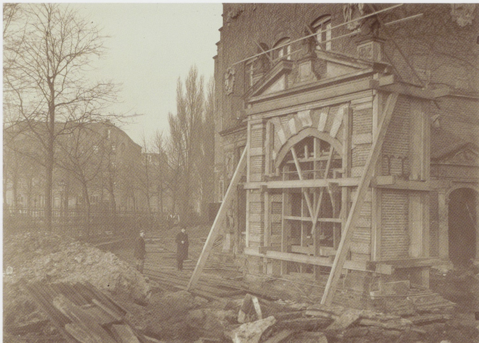
Afb. 4 Verplaatsing van de Poort van het Duitse Huis om terrein vrij te maken voor de bouw van de (eerste) Druckerzalen, 1906. Fotoarchief Rijksmuseum, Amsterdam.
